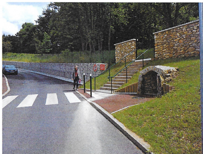
L'entrée ouest récemment aménagée
