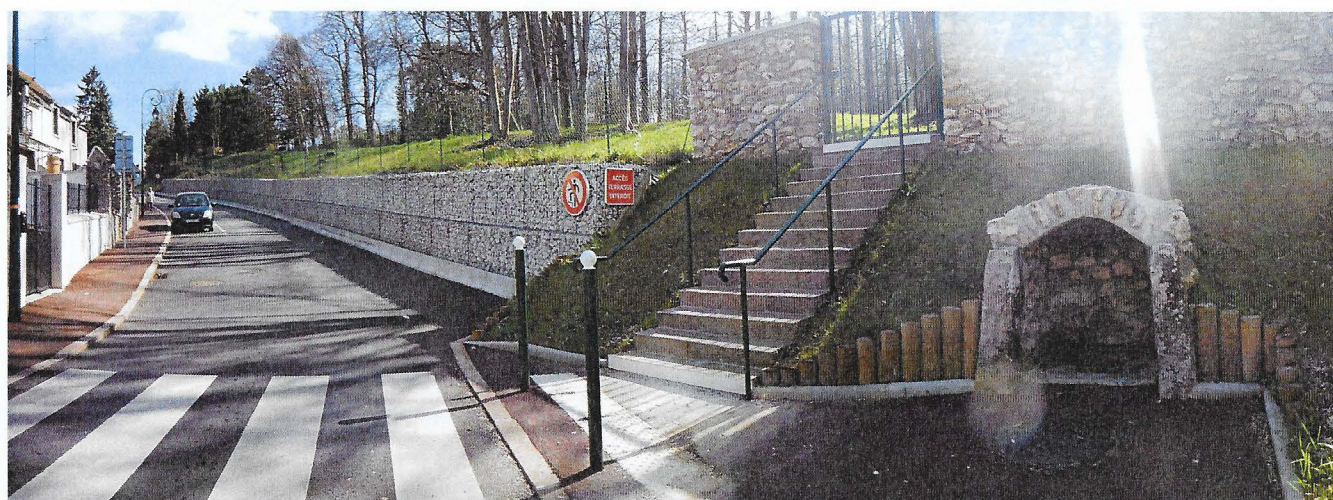
Entrée ouest : le dessin de cet aménagement et les matériaux employés (gabion, bordure béton, clôture treillis soudé) sont en rupture avec le dessin du parc à venir
