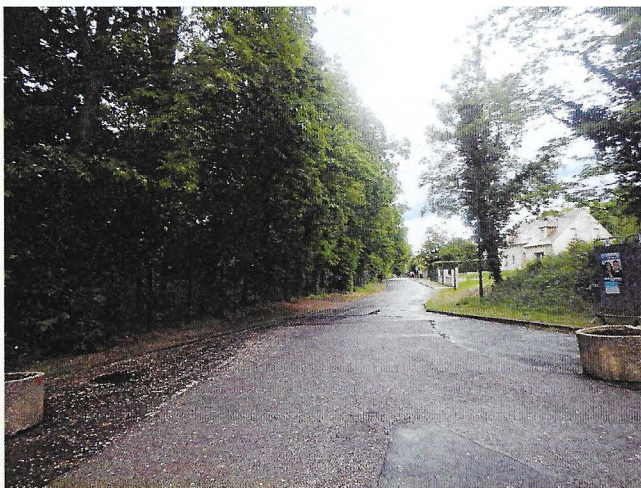
Rue du château rouge, la clôture actuelle
