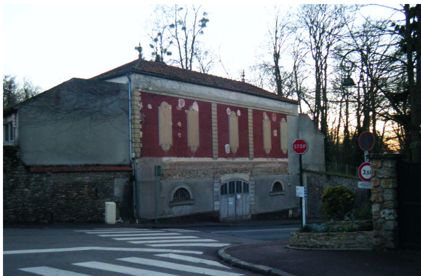
Figure 90: Une façade témoin des interventions architecturales successives sur l'orangerie
